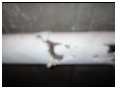
Photo N° 881 ECH-N°1 CALORIFUGEAGE -- DEGAGEMENT -1 Conduits de fluide Liège + plâtre
